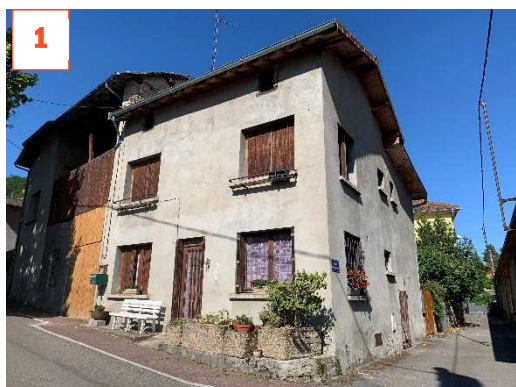
Ilot 1 : forme urbaine noyau historique Source : photo mairie
