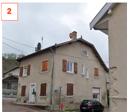
Ilot 2 : forme urbaine noyau historique Source : photo mairie
