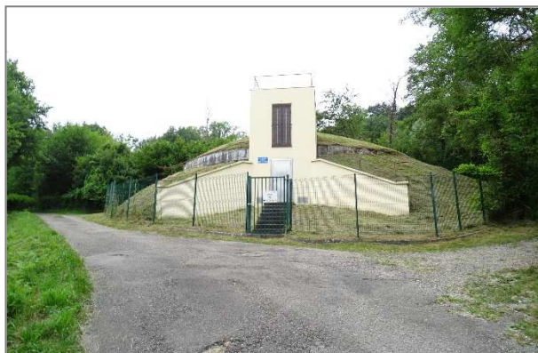
Réservoir des Blâches
