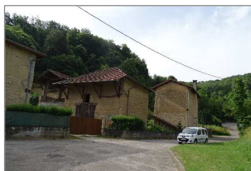
Bâti ancien dans le bourg
