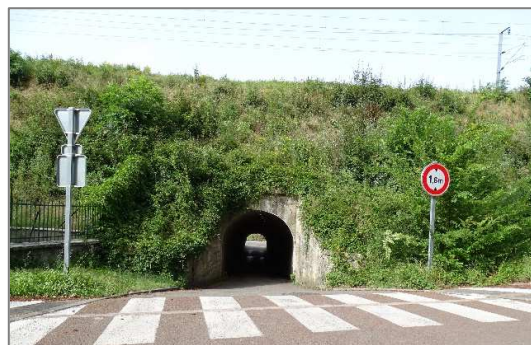
Ouvrage de franchissement en passage sous la voie ferrée (chemin du Crêt/Av. Ferronnière)
