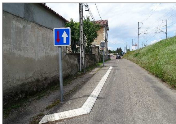
Alternat présent sur la rue de la Maladière au droit du secteur d'OAP
