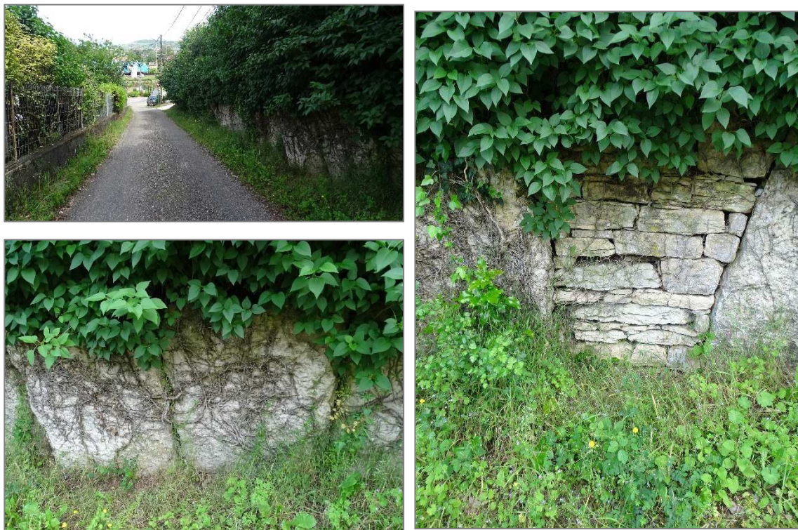
Mur de pierres plantées le long de la montée de la Maladière
