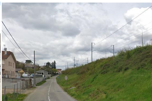
Vue au Sud du talus de la voie ferrée
